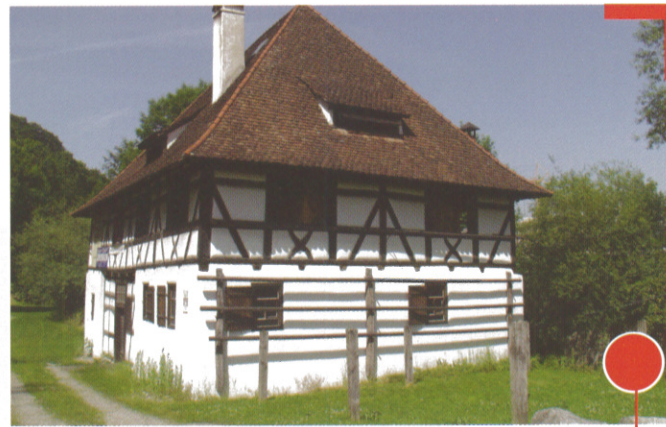
Sanierung und Restaurierung der letzten Altsämschgererei in 88400 Biberach, Ehinger Straße. Erbaut 1699 – Sanierung von Ende 1989 bis Mitte 1992. Folgende Leistungen wurden von uns ausgeführt: - Sanierung des sichtbaren Außenfachwerkes sowie Sanierung und Instandsetzungsarbeiten am Deckenbalk und an der Dachkonstruktion. - Rekonstruktion der alten Fenster mit Läden
