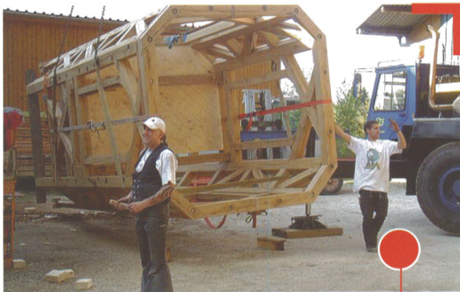
Verladen des neuen Dachreiters (Glockenturm) für die Kirche Maria-Magdalena in Großschaffhausen. Fachwerkkonstruktion in Eiche.
