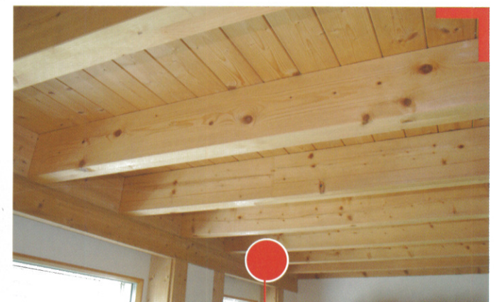
Sichtbare Holzbalkendecke in Fichte
