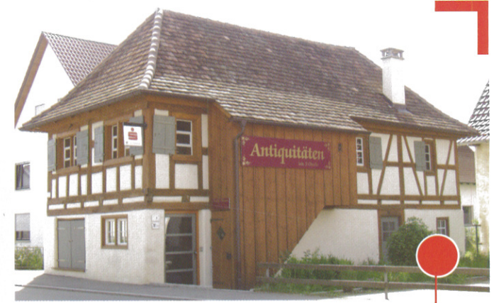
„Alte Schmiede“ in 88427 Bad Schussenried/Steinhausen. Erbaut ca. 1730, Sanierung im Jahre 1999 außen und innen. Folgende Leistungen wurden von uns ausgeführt: - Sanierung des Sichtfachwerkes außen und innen - Sanierung der Dachkonstruktion - Sanierung und Aufbereitung vorhandener Bretterböden
