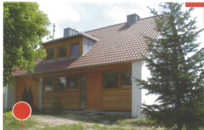
Modernisierungsarbeiten an einem Einfamilienhaus einschl. einer kompletten Dachsanierung mit Aufdämmung. Einbau einer Dachgaube.
